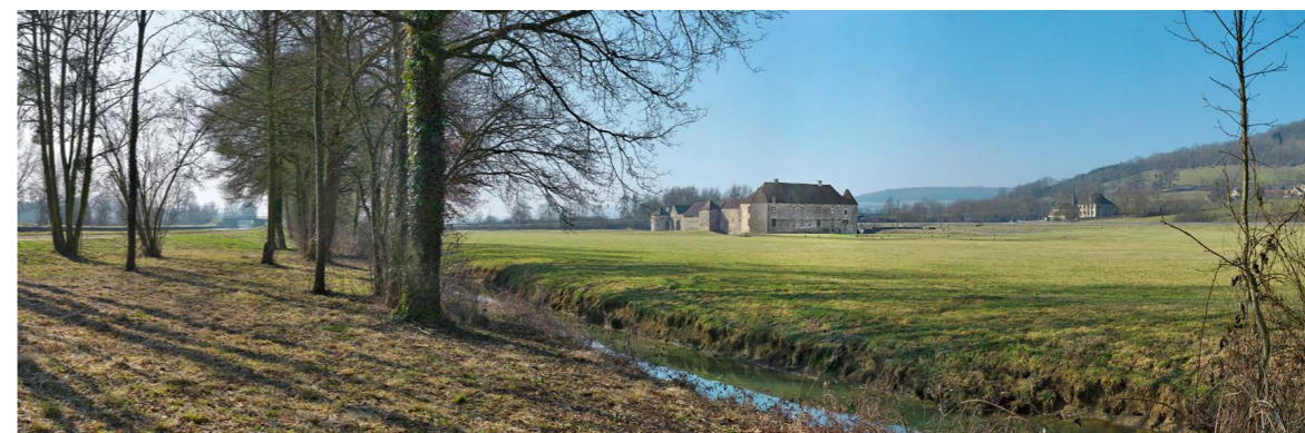
▲ Fig. 15 : château d'Éguilly. À gauche, en arrière-plan, pont sur le bief 13 du versant Yonne du canal de Bourgogne. (© T. Kuntz, Service Patrimoine et inventaire, Région Bourgogne, 2012.)
