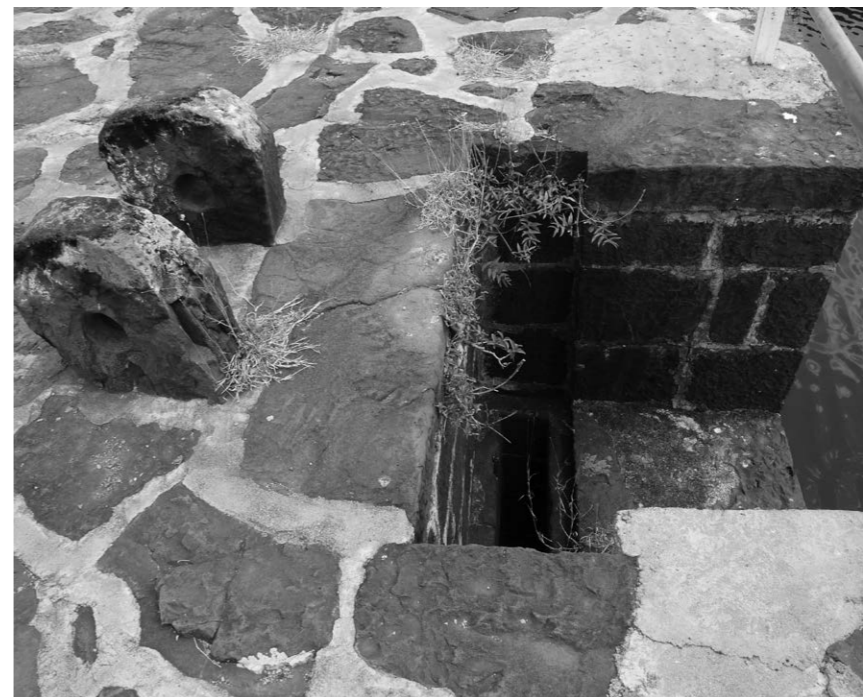
◀ Fig. 10 : écluse située sur la partie sommitale du barrage (cl. N.M.).
