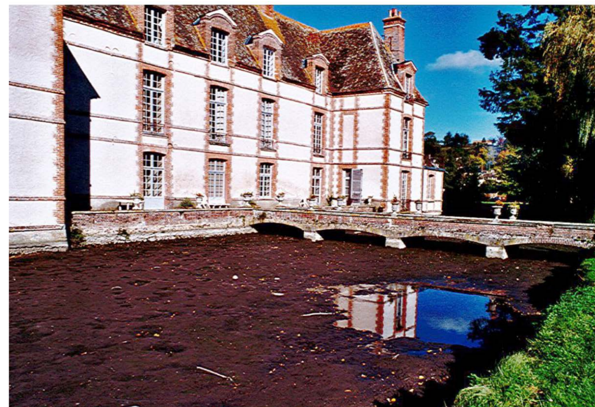
▲ Fig. 3 : le château de Saint-Lubin-des-Joncherets (28) avec ses douves à sec. (Cl. J.-L. Latour, -architecte 2013).
