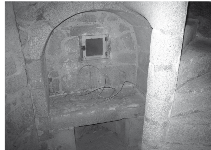
◀ Fig. 26 : évier aménagé au pied de la tourelle d'escalier.
