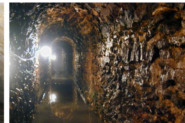
▲ Fig. 10 : aqueduc du Couchant, 1679-1682 (cl. Br.B.)
