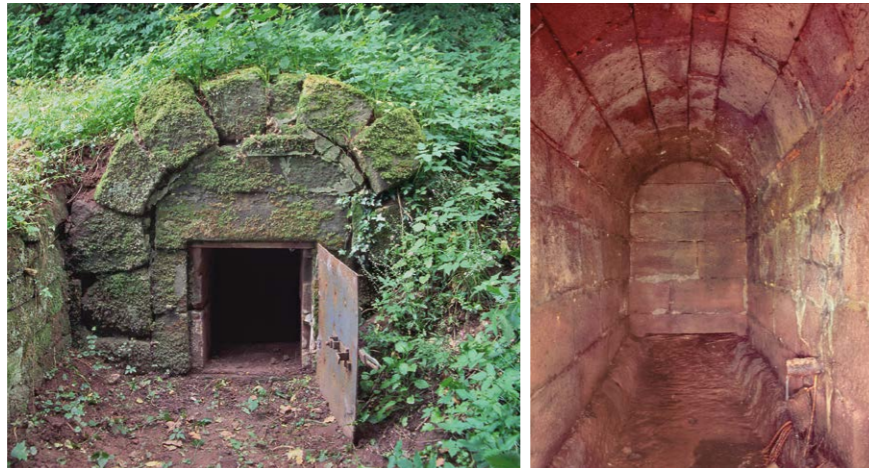
►► Fig. 28 : château de La Petite-Pierre. Intérieur de la chambre de captage 4 (cl. Uwe Wëlz, 2006).
