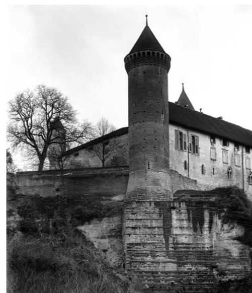
▲ Fig. 4 : château de Chenaux vu depuis le nord, vue de 1920. Avant 1879, le lac s'étendait jusqu'au pied de la falaise. Le gros contrefort en grès coquillier a doublé la falaise en 1785-1786 aux fins de stabiliser la tour de brique. À gauche de cette dernière, le mur-digue qui fermait le fossé nord, restauré en 1917-1919 ; à droite, restes du mur de braie occidental (cl. SBC, fonds Reiners).
