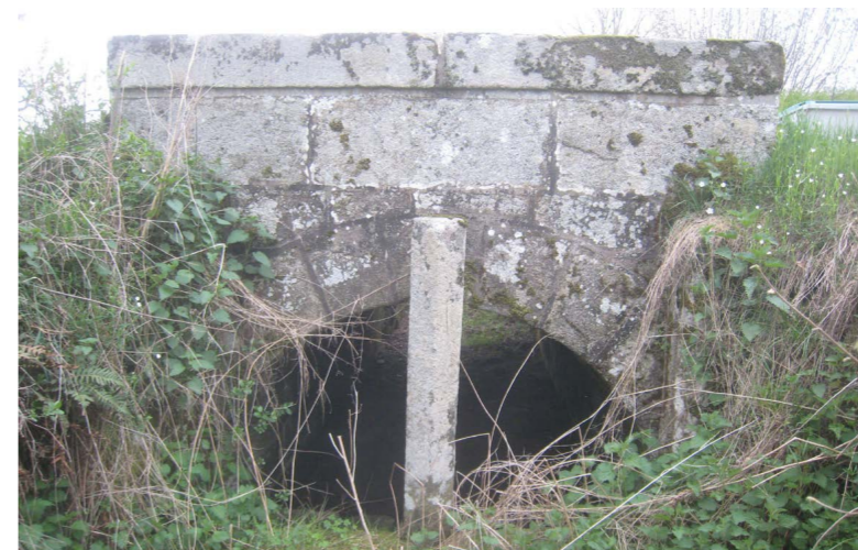
▲ Fig. 18 : vanne à double surverse.
