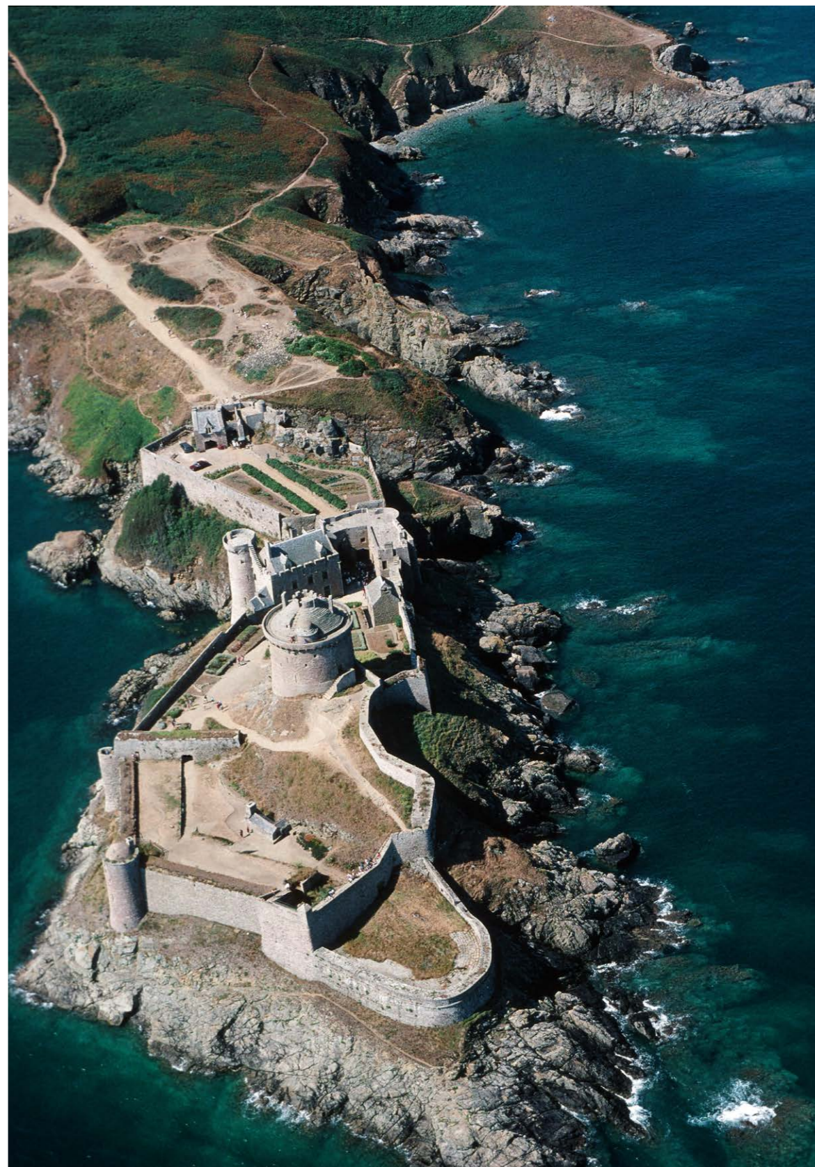
▲ Fig. 14 : château de Fort La Latte ou La Roche-Goyon à Plévenon (cl. M. Gautier).
