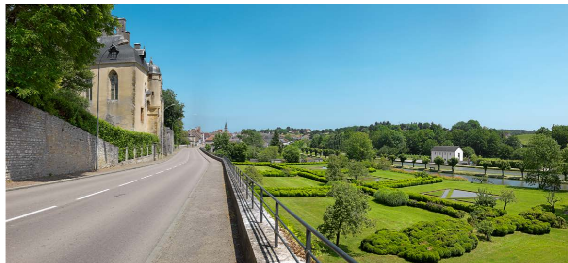
▼ Fig. 16 : château de Châtillon-en-Bazois, séparé de ses jardins et viviers par une route ; canal du Nivernais, bief 15 du versant Loire. (© T. Kuntz, Service Patrimoine et inventaire, Région Bourgogne, 2013.)
