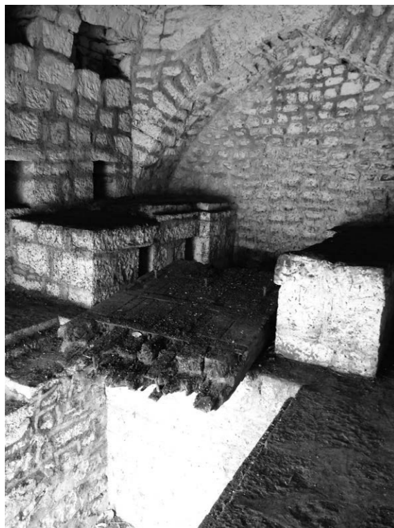
▲ Fig. 11 : arrivée d'eau à l'intérieur du barrage (cl. N.M.)
