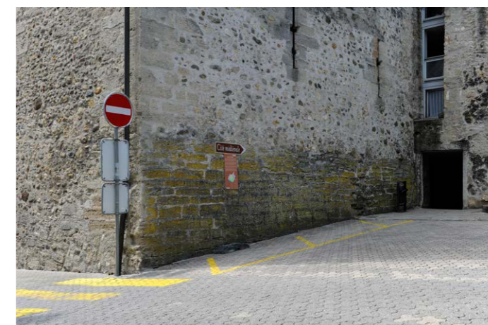
▲ Fig. 9e : restes du mur méridional de la Chaussée, pris dans la grosse tour des Dominicaines. Il se reconnaît par son parement en grès coquillier ; son léger fruit ayant permis l'accroche de mousses et lichens verdâtres. On constate aussi qu'il a été arraché et que cet arrachement a été reparementé : la chaîne d'angle de la tour ne commençant que derrière le panneau de signalisation (cl. D.R. 2015).
