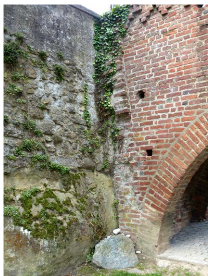
▲ Fig. 7 : château de Chenaux, pont oriental du châtelest, amorce du parement en brique taluté qui aurait dû couvrir la contrescarpe du fossé (cl. D.R. 2015).
