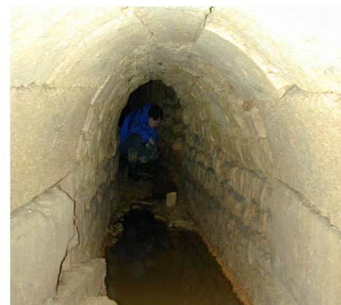
▲ Fig. 15 : aqueduc de la Terrasse, 1679-1684 (cl. Br.B.)
