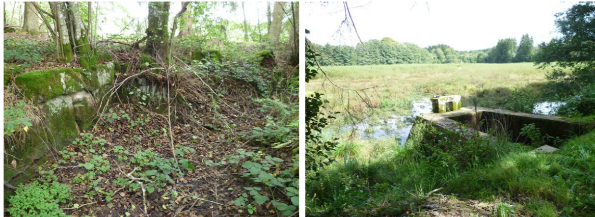
▲ Fig. 6 : canal de contournement de l'étang de la Combe.
