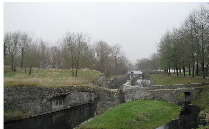
◀ Fig. 11 : vue de l'écluse des Longues Masses et de ses batardeaux (cl. Y.R.)
