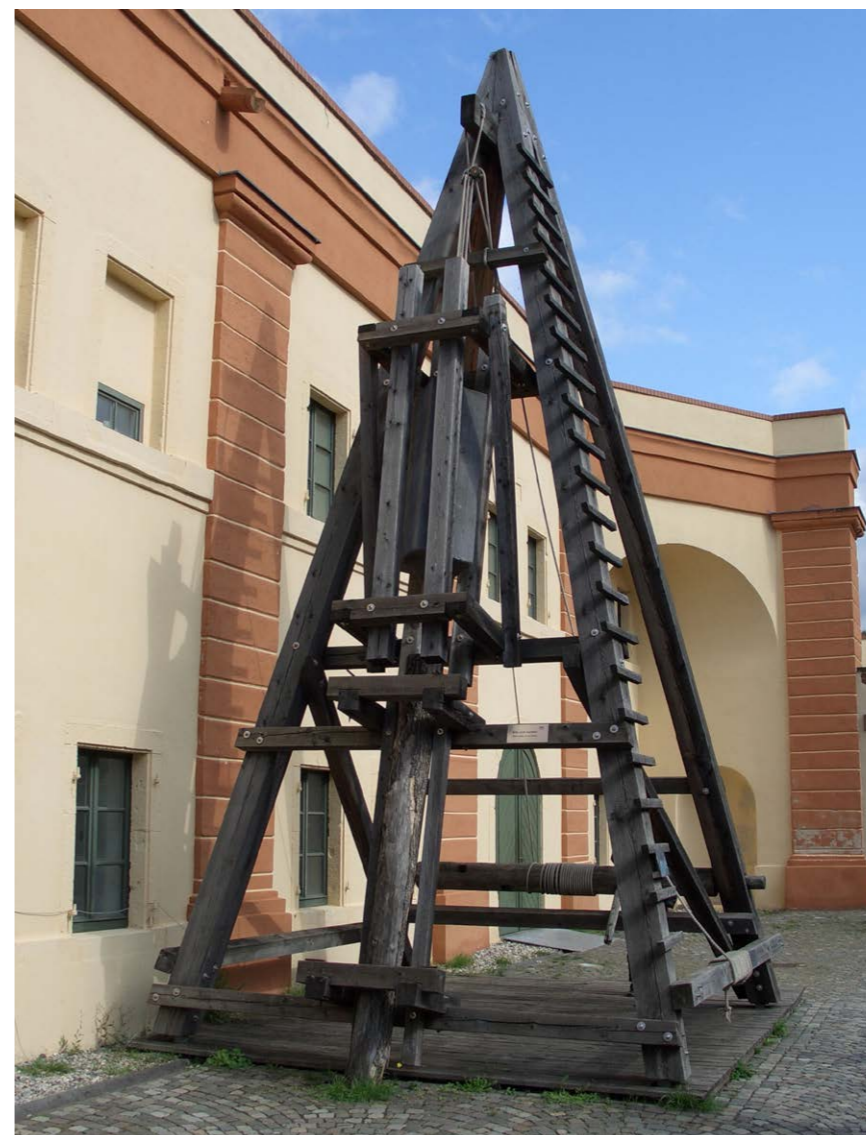
◀ Fig. 4 : reconstitution d'une machine romaine utilisée lors de la construction du pont sur le Rhin par Jules César en 55 av. J.-C. Coblenz, Festung Ehrenbreitstein (cl. Wikipédia).
