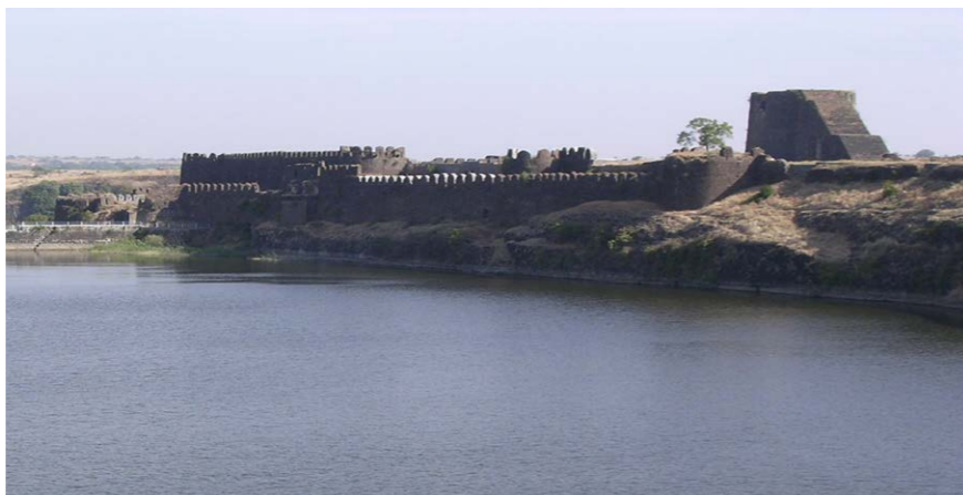
► Fig. 8 : lac de retenue et barrage en arrière plan.
