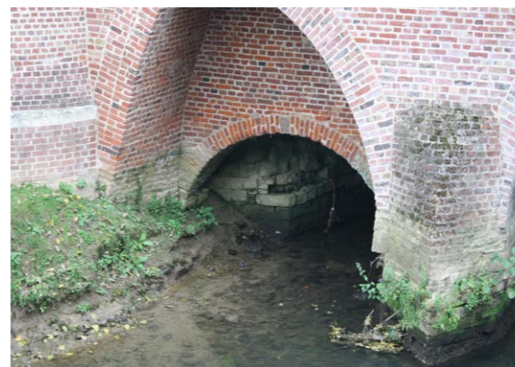
▲ Fig 5 : détail de la base de la Porte du Beaulieu à Aire en septembre 2014. Au centre de l'image, l'appareillage de la base rappelle la technique de construction en « joints beurrés » qu'on utilisait pour les grès des châteaux d'Aire et Saint-Omer au XIII e siècle. L'arche utilise des briques telles qu'on commence à les produire dans la ville au XV e siècle puis au XVI e siècle : cette partie pourrait avoir été reprise lorsque la ville passa sous le contrôle du Louis XI ou sous Philippe II. Le reste semble bien plus postérieur (cl. B.H.)
