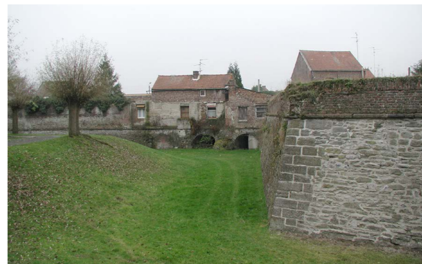
◀ Fig. 9 : vue de l'écluse des Trois Troues (cl. Y.R.)
