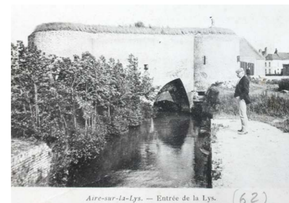
▲ Fig 6 : porte du Beaulieu au début du XX e siècle. La canonnière, semblable à celles qui apparaissent dans les comptes de travaux du XV e siècle, n'a pas encore été rebouchée à cette époque : elle donne une bonne idée de la hauteur de l'eau en cas de crue (carte postale, 9 x 14 cm, début du XX e siècle, collection privée).
