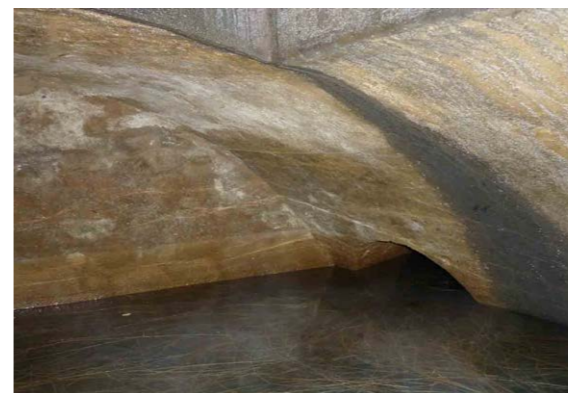
▲ Fig. 9 : aqueduc du Village, 1679-1682, chambre de captage (cl. Daniela Malnar).
