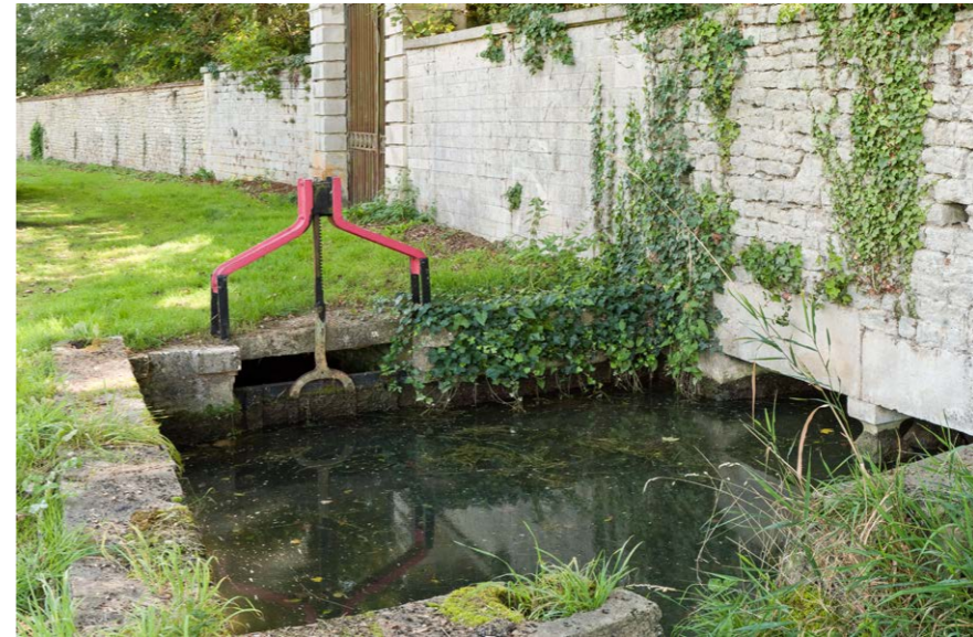
◀ Fig. 8 : bassin recevant les eaux du parc du chateau de Nogent-lès-Montbard avant de les rejeter au canal ; canal de Bourgogne, bief 63 du versant Yonne. (© P.-M. Barbe-Richaud, Service Patrimoine et inventaire, Région Bourgogne, 2011.)
