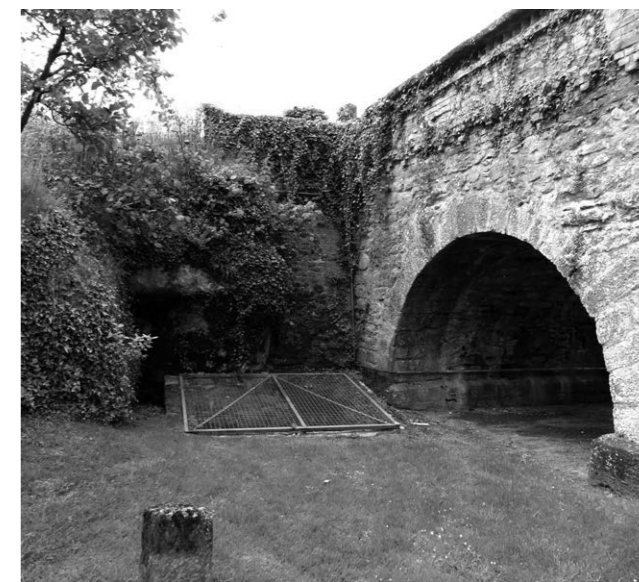
▲ Fig. 5 : château de Chenaux, fossé oriental. À gauche du pont d'accès de 1507, contrescarpe du fossé taillé dans la molasse avec l'entrée d'une galerie de captage de source ; à l'avant, un puits. Ces sources alimentent le bassin situé dans le fossé méridional du fossé (cl. D.R. 2015).
