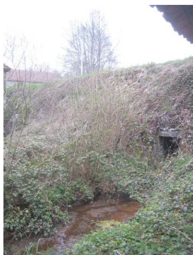
▼ Fig. 13 : prise d'eau de la seconde unité de meunerie.
