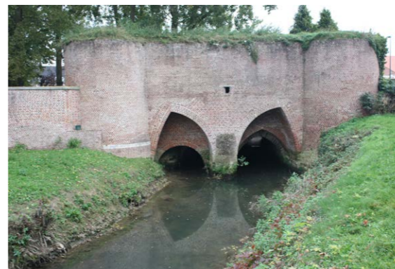
▲ Fig 3 : le « servoir » d'Aire dit « Porte du Beaulieu ». Par cette double arche, les eaux de la Lys pénètrent dans la ville. Fortement remanié à l'époque moderne (au XVII e siècle sous Philippe II puis au XVIII e siècle avec les aménagements de Vauban), l'ouvrage n'a conservé de son passé médiéval que sa base dont l'appareillage n'est pas sans rappeler les descriptions apparaissant dans les comptes de travaux du château pour le XIV e siècle (cl. B.H.)
