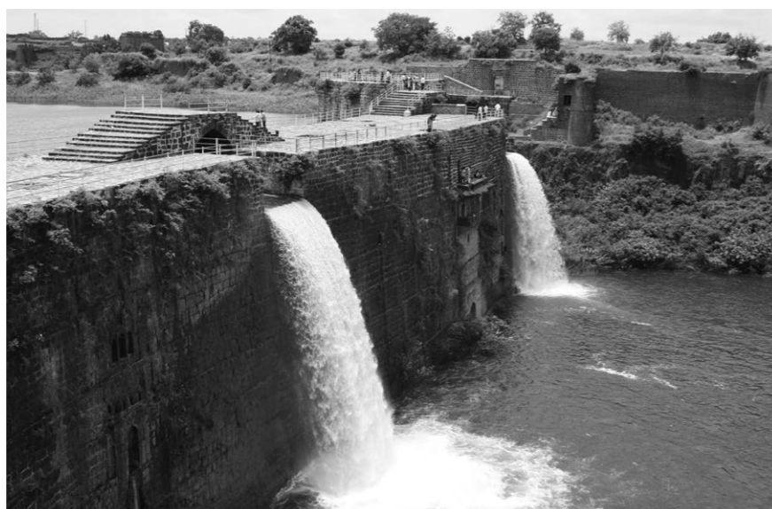
► Fig. 6 : lâcher d'eau du barrage (cl. N.M.)
