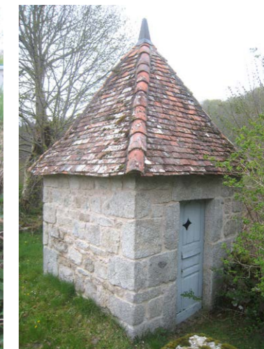
▲ Fig. 19 : pavillon de latrines de la maison seigneuriale.
